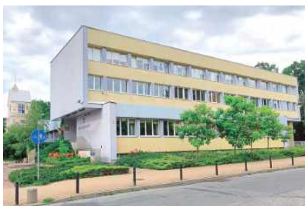
Niebawem działka z siedzibą sądu i prokuratury zmieni się w plac budowy. Prace mają potrwać prawie 3 lata
