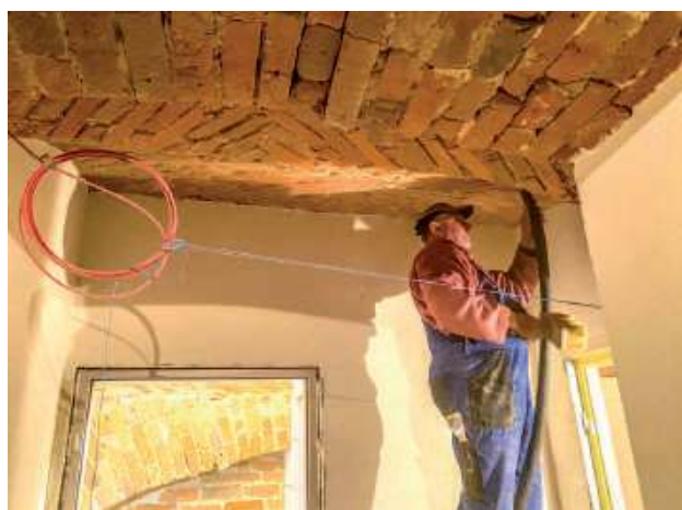
W piwnicach bialskiego magistratu trwają zaawansowane prace remontowe
