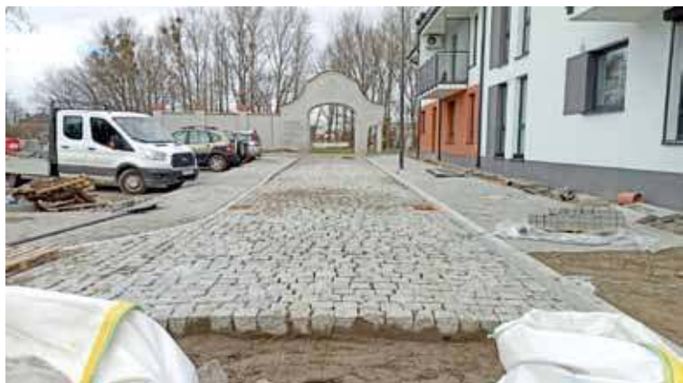
Nowa jezdnia na ul. Kasztelańskiej będzie wykonana z kostki kamiennej rzędowej
