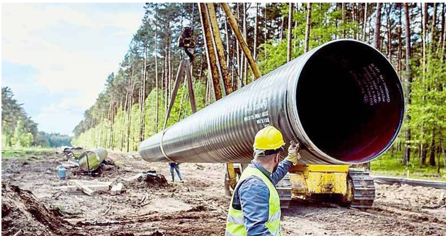
Zakończyła się przebudowa gazociągu Goleniów Police
