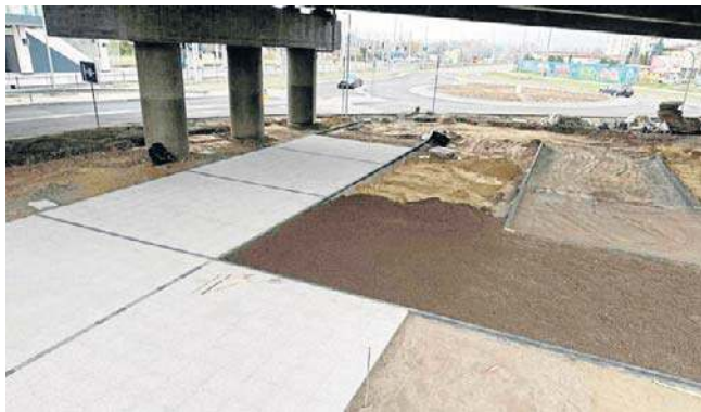
Na przyszłym placu pod wiaduktem pojawiły się już płyty.
