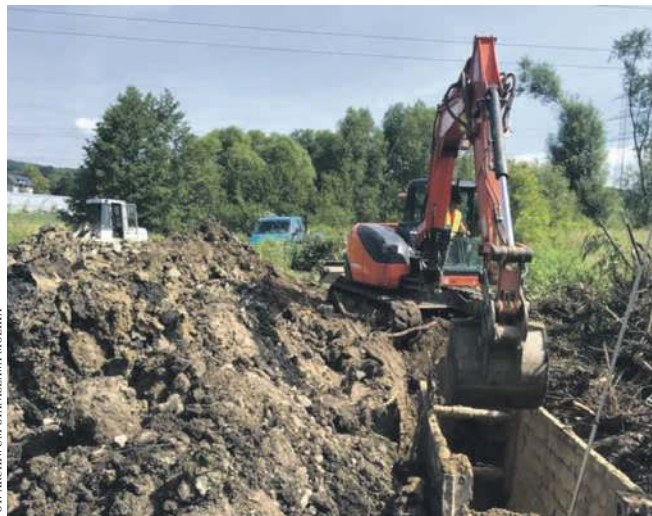
Rozpoczęła się budowa kanalizacji w Siedlecu
