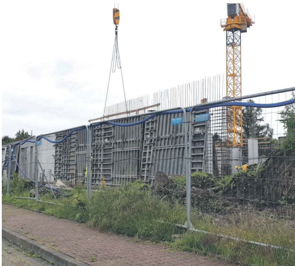
Na działce przy alei Solidarności w Krzeszowicach prace idą pełną parą
