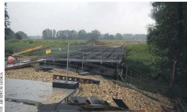
Trwa budowa nowej drogi
