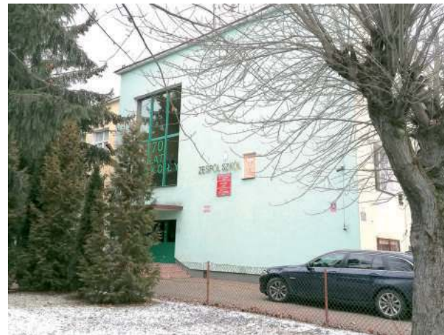
Budynek Zespołu Szkół w Chodlu. Własność powiatu. Uczy się w nim obecnie 14 uczniów IV klasy Technikum Budowlanego. Budynek był budowany w czynie społecznym przez mieszkańców, którzy przekazali też cztery działki pod jego budowę
