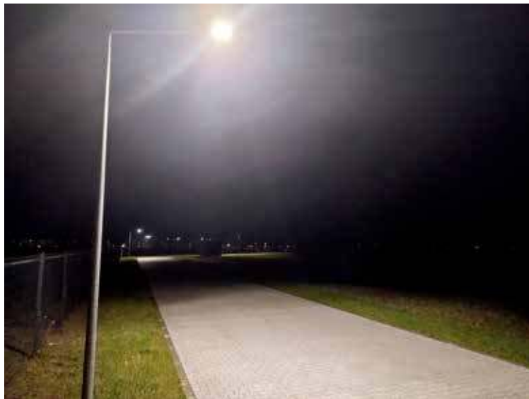
Lądowisko dla helikopterów oświetlone, ale LPR lądować tu jeszcze nie może
