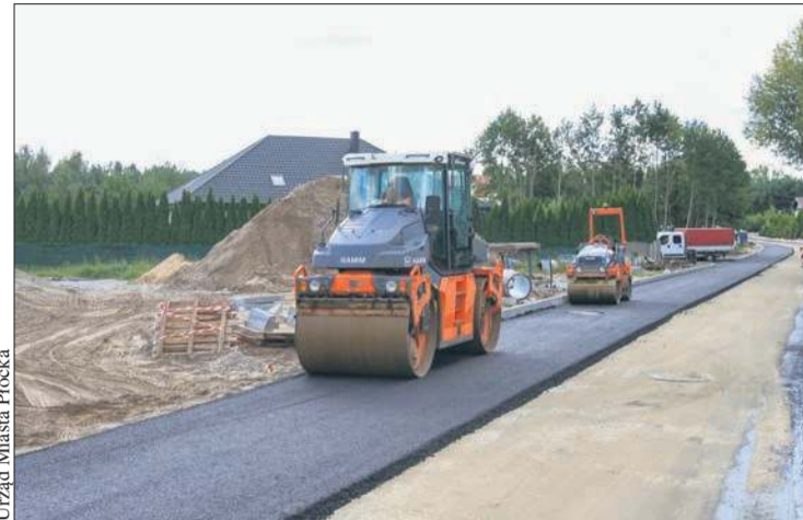
Trwa przebudowa ulicy Browarnej
