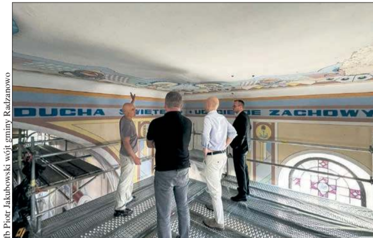
W kościele parafialnym pw. św. Floriana w Radzanowie trwają prace konserwatorskie
