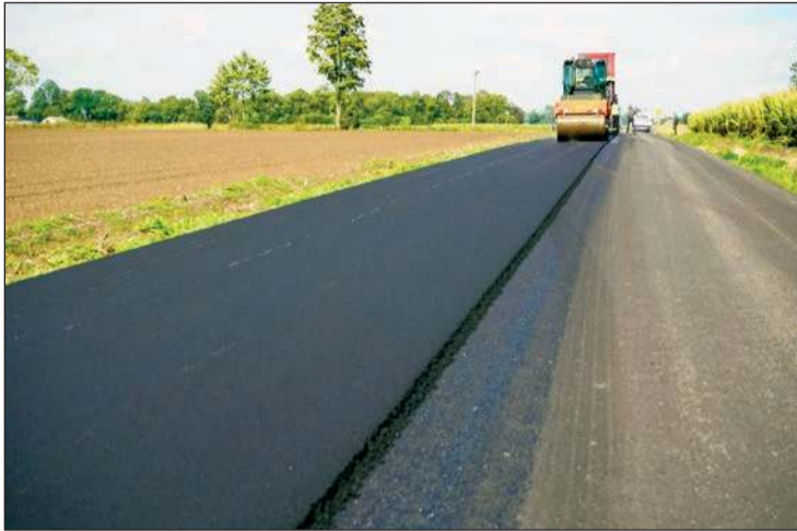
Wylewanie nowej nawierzchni to jeden z ostatnich etapów inwestycji
