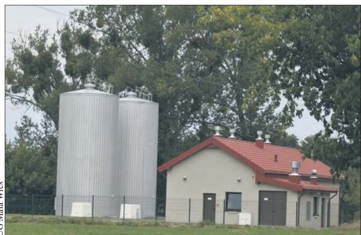
Tak wygląda nowoczesna stacja uzdatniania wody w Lasocinie
