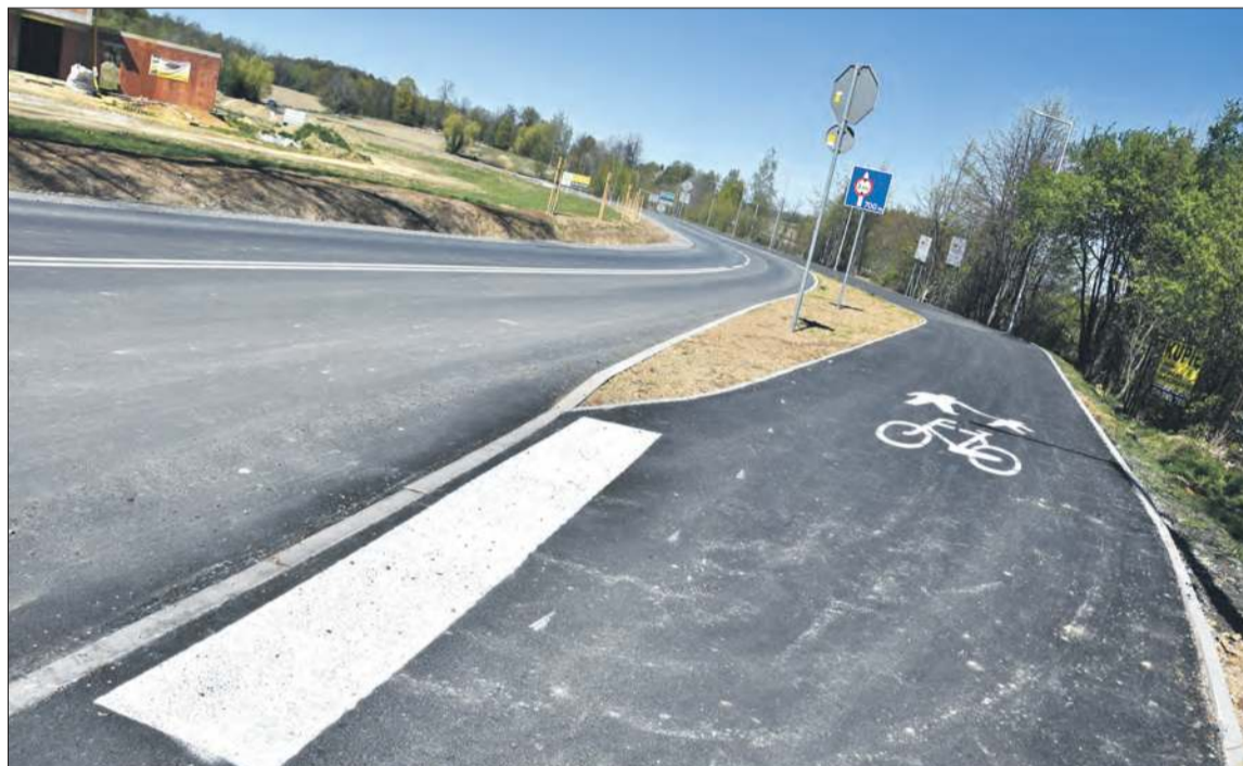
Nowy odcinek drogi od strony Pokrzywnej
