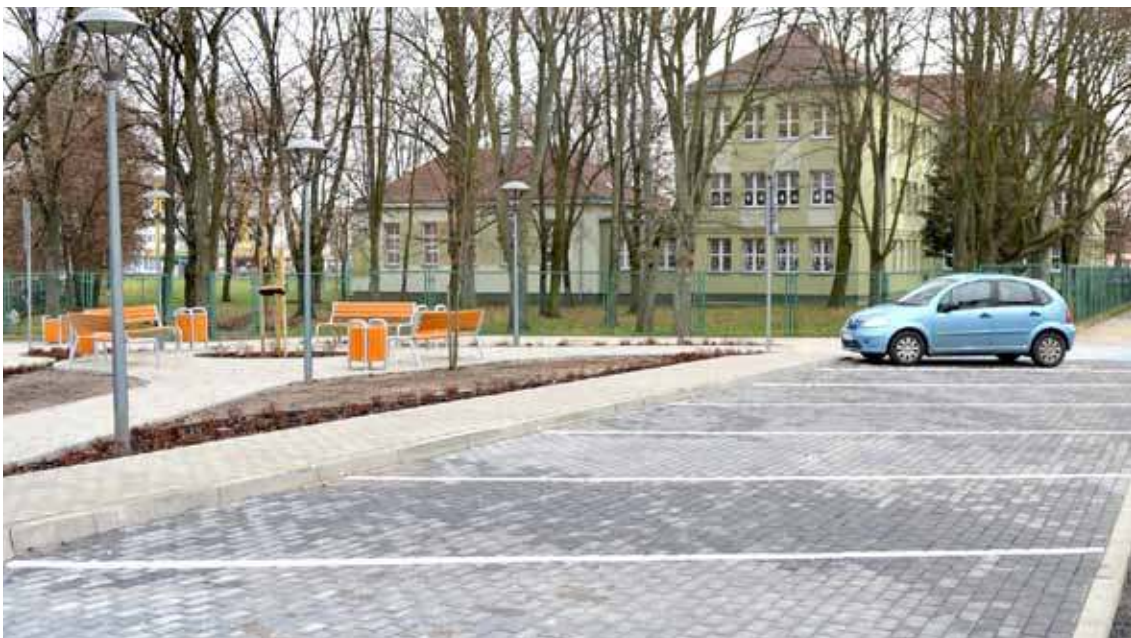
Przy Szkole Podstawowej nr 4 powstało 18 miejsc parkingowych. Wykonano nowy chodnik oraz postawiono ławki
