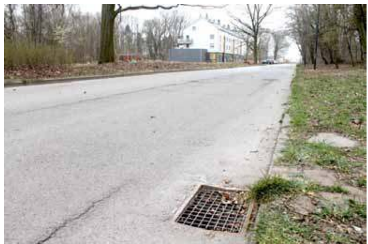
Na razie położono tymczasowe zabezpieczenie
