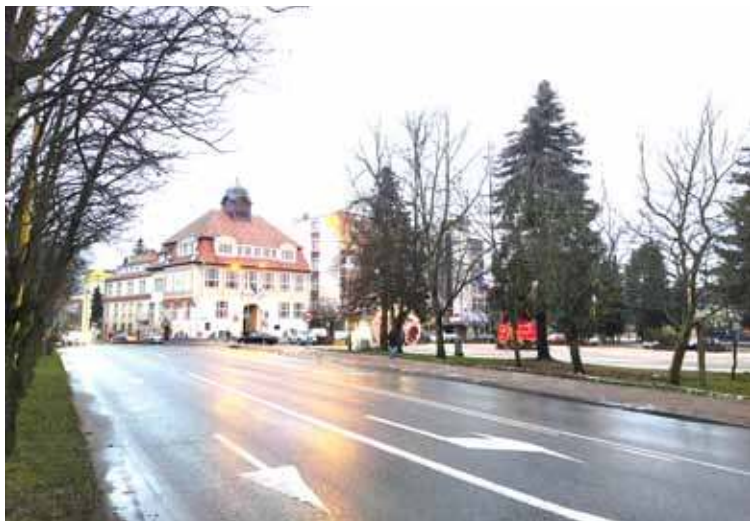
Zagwarantowanie finansowania przebudowy Pl. Wolności umożliwi podpisanie umowy z wykonawcą
