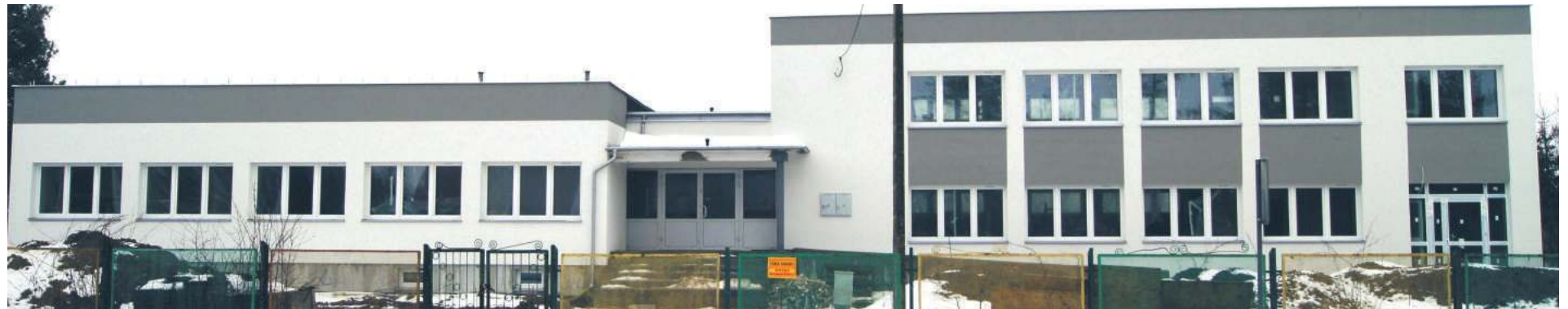
Remontowany budynek po Ośrodku Zdrowia w Kamieniu
