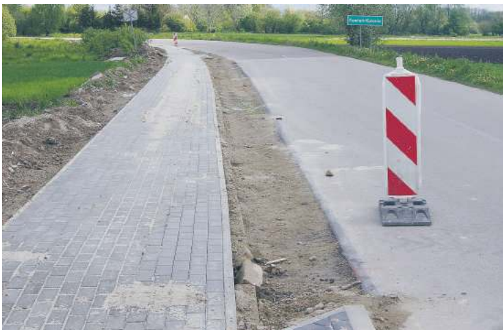
Modernizacja drogi w Kamieniu-Kolonii
