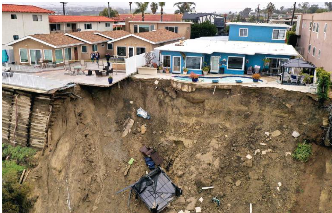
W Oceanside w Kalifornii potężne ulewę spowodowały osunięcie się ziemi. Mieszkańcy domów na wybrzeżu zostali ewakuowani. 15 marca 2023 r.
