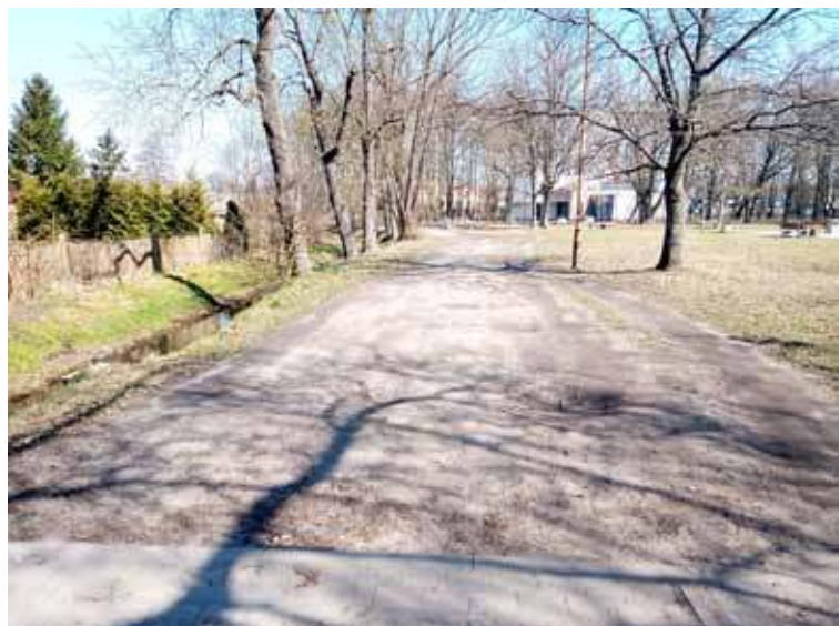
Od strony ulicy Ochronnej wskazane jest wykonanie na opisywanej drodze dojazdowej utwardzenia
