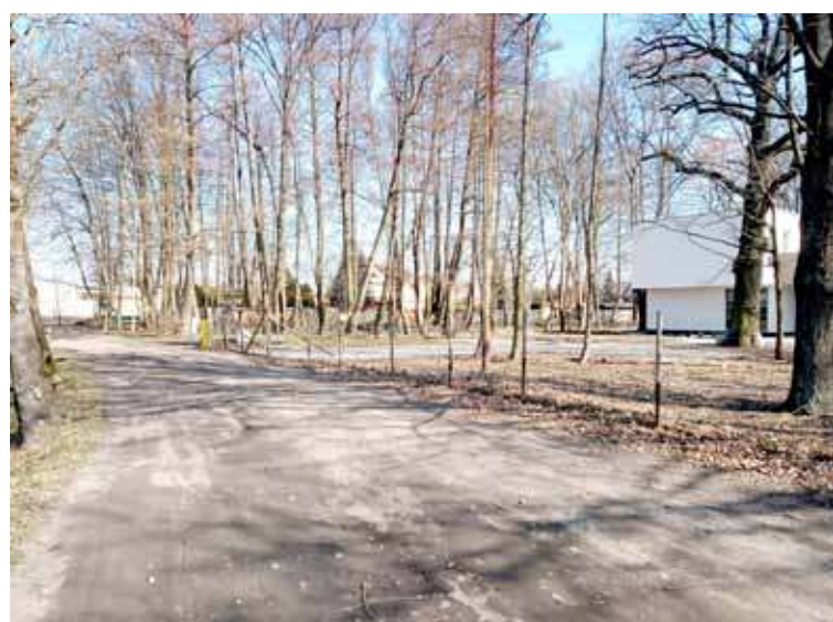
Jak widać, powierzchnia nie jest utwardzona, co powoduje powstawanie błota w czasie opadów deszczu
