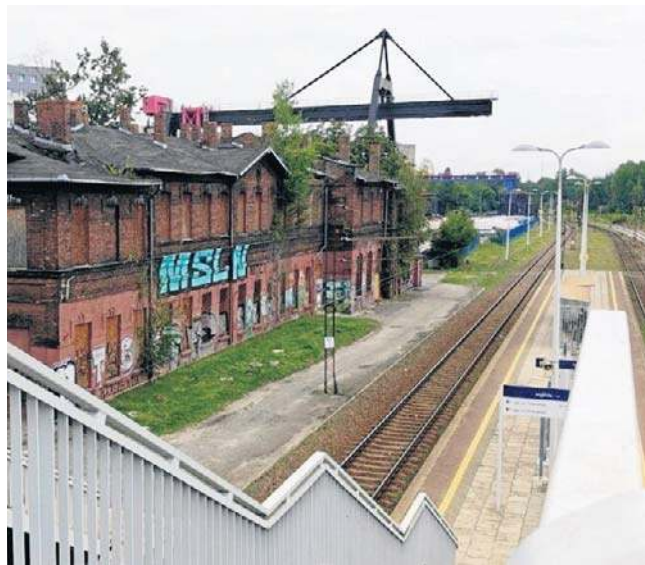
Tak stacja Sosnowiec Południowy i budynek dworca prezentują się obecnie
