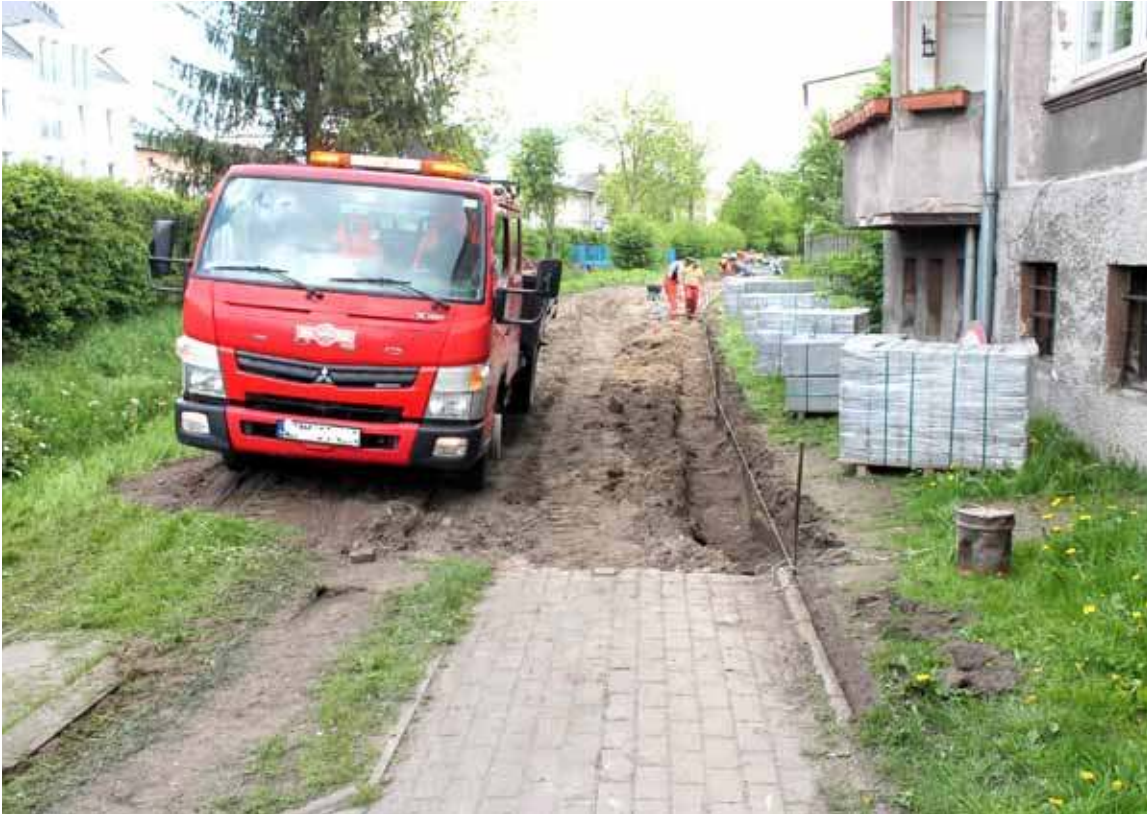
W tych dniach na Bydgoskiej trwają właśnie prace nad remontem chodnika
