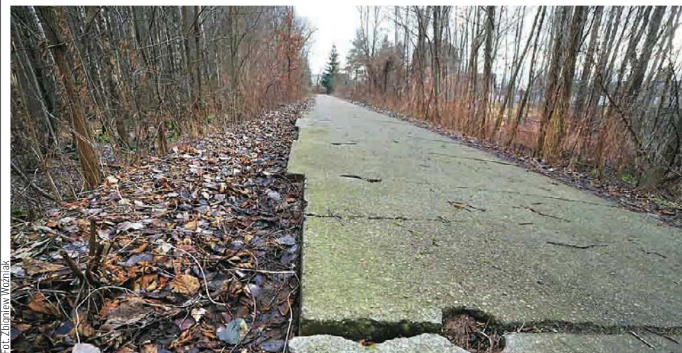
Tędy m.in. ma przebiegać planowana ul. Nowobałtycka
