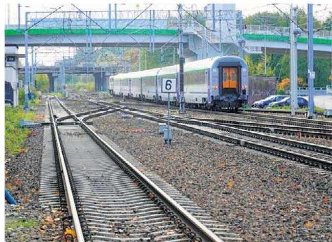
Pociągi wrócą do Jastrzębia-Zdroju. Poinformowano o ogłoszeniu przetargu na odbudowę torów do tego miasta
