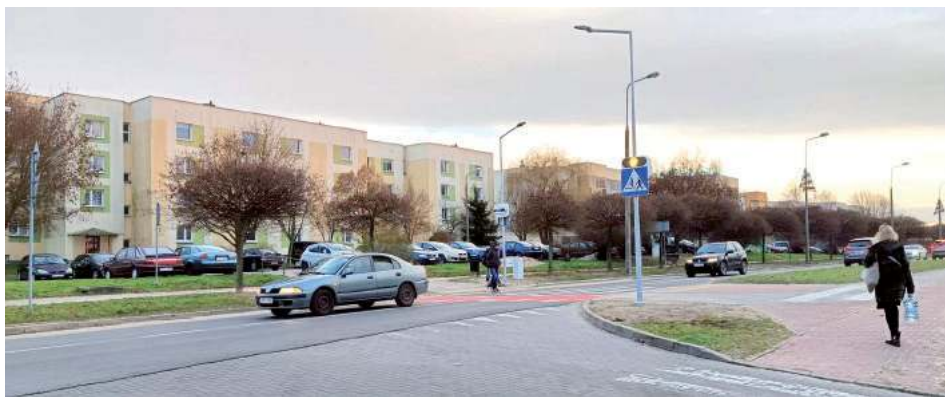
Teraz gdy pieszy zbliża się do pasów, automatycznie zaczyna migać pomarańczowe światło nad znakiem przejścia dla pieszych i pulsują tzw. „oczka” zamontowane w asfalcie
