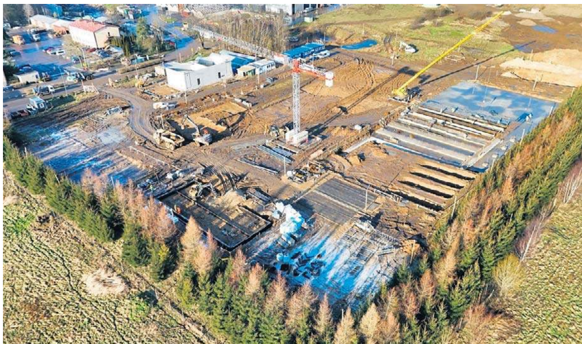
Przy budowie instalacji do suchej fermentacji odpadów obecnie trwają prace ziemne
