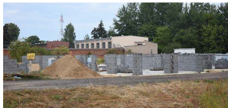
Żłobek miejski ma być gotowy w połowie przyszłego roku.
