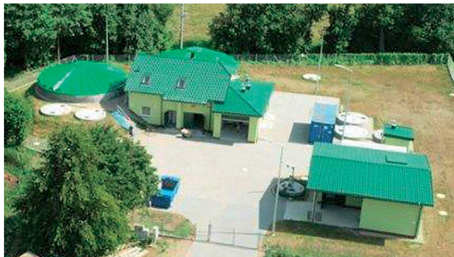
Oczyszczalnia ścieków w Nowym Mieście
