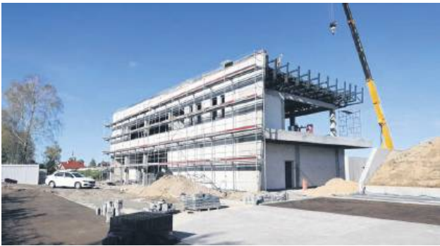
Prace na autodromie dobiegają końca.
