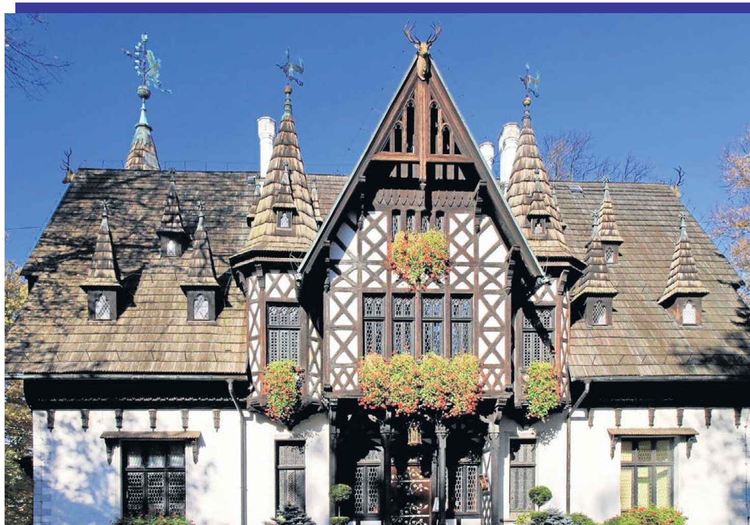
Zameczek myśliwski w Promnicach przeszedł gruntowną rewitalizację, która trwała prawie osiem lat.
