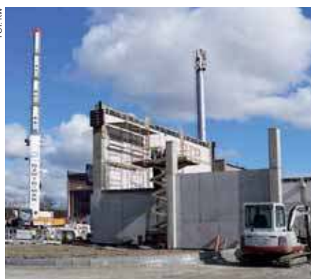
Prace w ciepłowni przy ul. Nidzickiej
