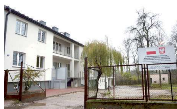
W ostatnich miesiącach obiekt przeszedł kompleksową termomodernizację
