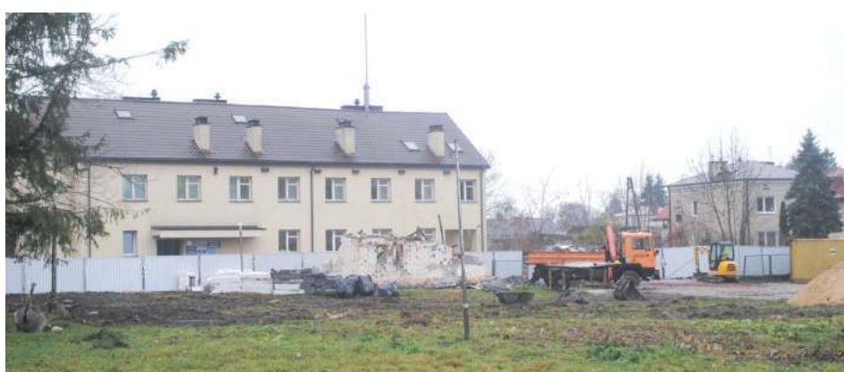
Plac budowy został już przekazany pod roboty przygotowawcze. Wykonawca wyciął już drzewa i może rozpocząć roboty związane z usunięciem kolizji sieci podziemnych z budynkiem pawilonu
