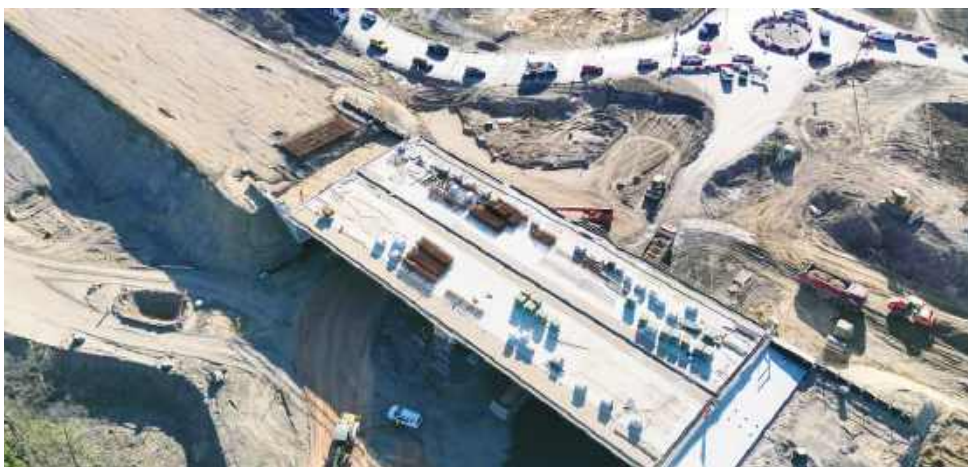
Przebudowa węzła Zegrze Południowe.
