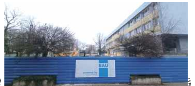
Jeszcze niedawno tu stało północne skrzydło budynku sądu. Zostało wyburzone, a w jego miejsce powstanie nowy obiekt
