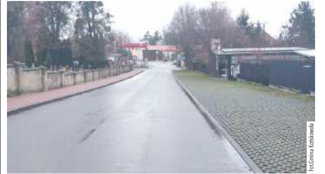
Jedną z wyremontowanych dróg na terenie gminy jest m. in. ul. Cmentarna w Końskowoli. Inwestycja pochłonęła 1,6 mln zł
