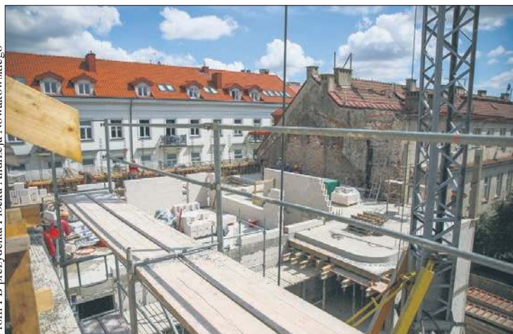
Prace przy ul. Grodzkiej 8
