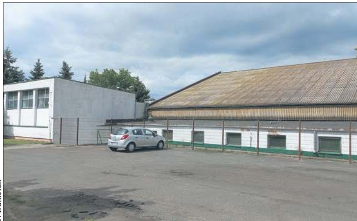
Pływalnia przy Al. Kobylińskiego zostanie wyburzona. W jej miejscu powstanie parking
