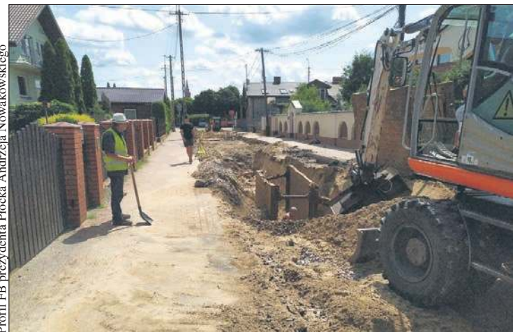
Trwa przebudowa kolejnego fragmentu ulicy Zielonej
