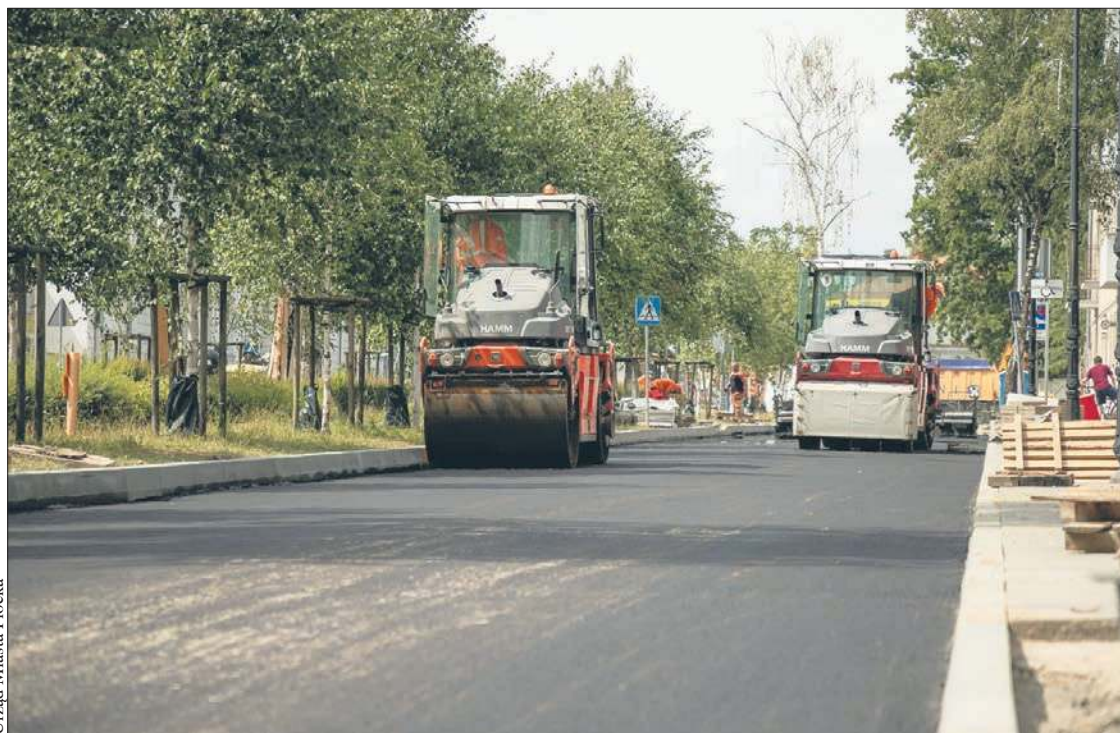
Układanie asfaltu na jezdni pl. Dąbrowskiego
