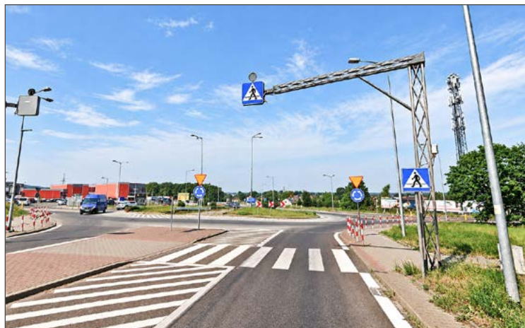
Przebudowa będzie wiązać się z utrudnieniami w ruchu, ale po zakończeniu robót ruch ma odbywać się płynnie.
