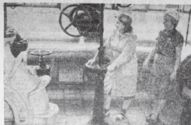
W przepompowniach ciepła z magistrali zmienia swoje parametry techniczne. foto: Wł. Dziurzycki
