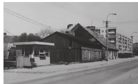
Nieistniejący kiosk przy ul. Płockiej na tle starej zabudowy Mławy
