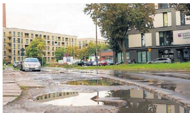
Dwukilometrowa ul. Milionowa będzie remontowana etapami
