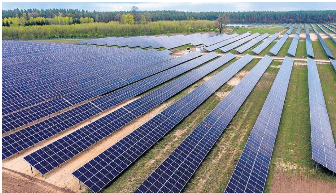
Na terenie Stacji Uzdatniania Wody „Zawada” powstanie farma fotowoltaiczna i największy w kraju (biorąc pod uwagę firmy wodociągowe) magazyn energii
