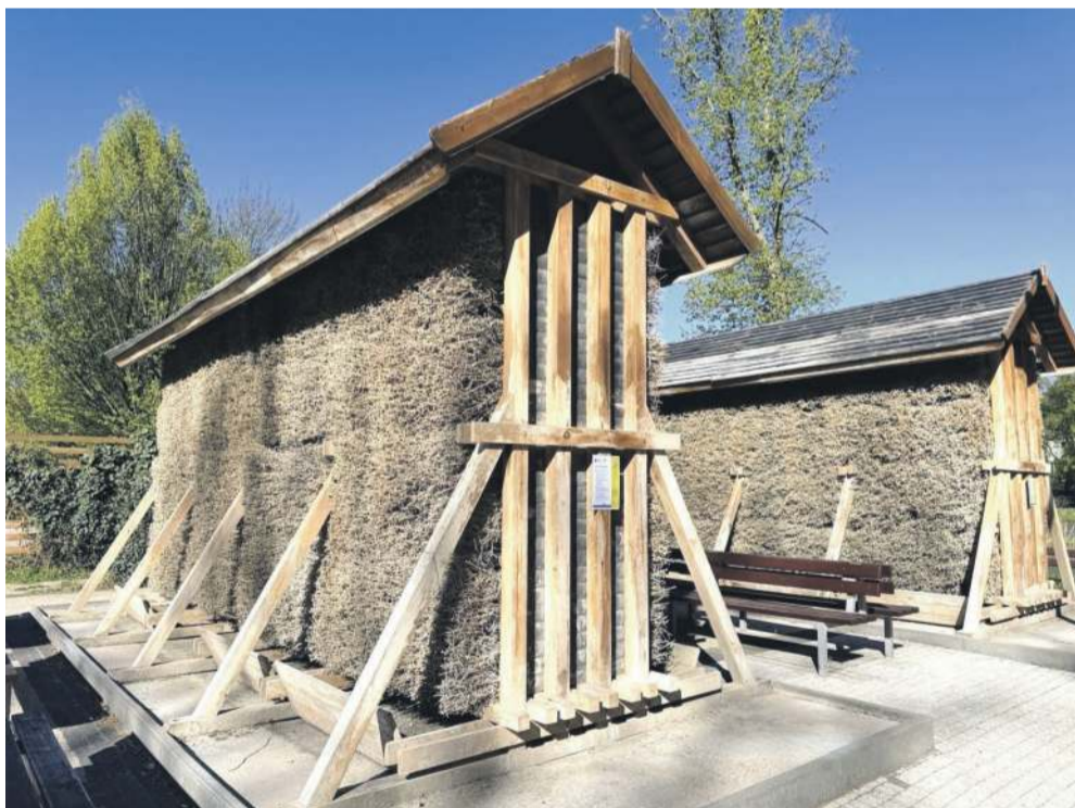
„Tężnie” stojące między stawami zasilają się solą z Kłodawy, która rozcieńczana jest zwykłą „kranówką”
