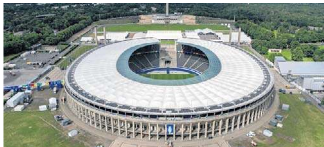
Olympiastadion w Berlinie. Rok budowy: 1934 (ostatnia renowacja: 2004). Pojemność: 74 000. Gospodarz finałów MŚ 2006, LM 2015 oraz Euro 2024 i meczu Polska - Austria (21.06).
