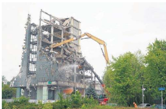
Dawny budynek Gazowni Łódzkiej przy ul. Uniwersyteckiej 2/4 traci kolejne piętra
