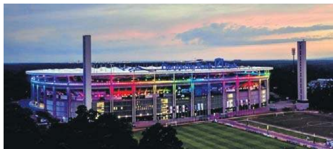
Frankfurt Arena we Frankfurcie. Rok budowy: 1925 (ostatnia renowacja: 2005). Pojemność: 48 057. Gospodarz finału Pucharu UEFA kobiet 2002 i 5 meczów Euro 2024.
