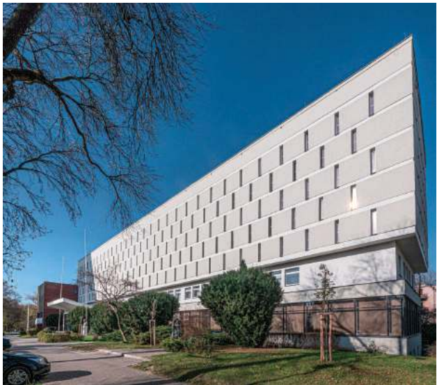
Gmach Biblioteki Głównej UMCS zajął piąte miejsce w kategorii „Budynek po termomodernizacji”. Obiekt o modernistycznej estetyce został zaprojektowany w 1963 r. przez Tadeusza Witkowskiego. Mieści się w centrum Kampusu Uniwersyteckiego, stanowiąc nieodłączny element jego krajobrazu. Dzięki profesjonalnie przeprowadzonej termomodernizacji budynku, obiekt zachował wszystkie detale charakterystyczne dla tej epoki
