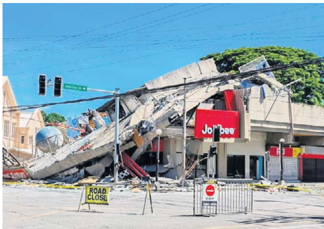
Trzęsienie ziemi nawiedziło południowe Filipiny. Uszkodzony budynek w General Santos
