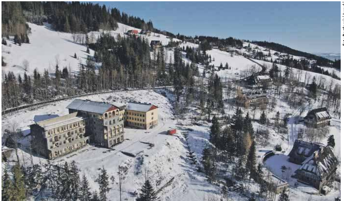
Zniszczona Salamandra to kompleks budynków z najpiękniejszymi na Podhalu widokami na Tatry.
