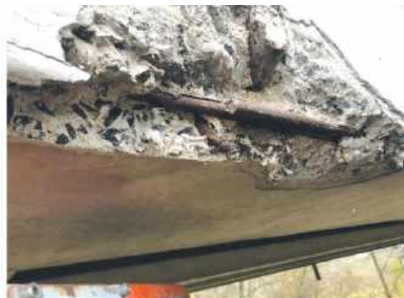
62. Ubytki, wykruszenie otuliny betonowej dźwigara głównego, korozja powierzchniowa odkrytego zbrojenia oraz kanału iniekcynowego.
