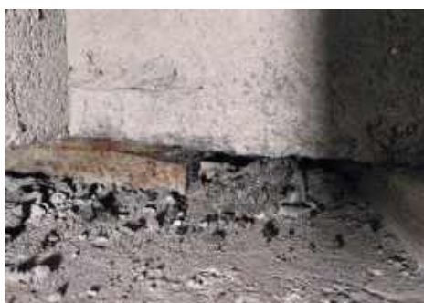
Stan łóżysk stalowych
