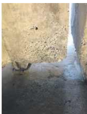
40. Zawilgocenia oraz rozsegregowanie mieszanek betonowej płaszczy betonowego dźwigara w strefie zakotwienia kabli srozeaiacvch.
