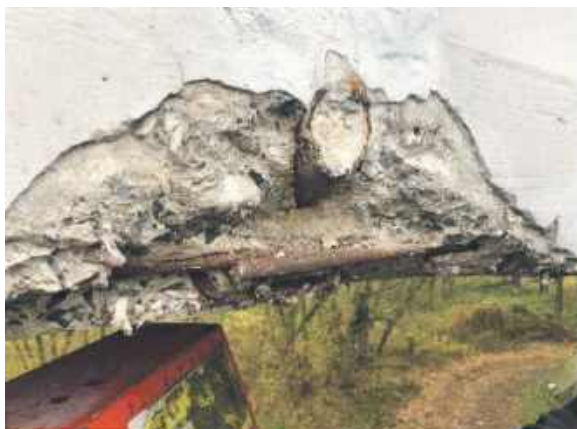
62. Ubytki, wykruszenie otuliny betonowej dźwigara głównego, korozja powierzchniowa odkrytego zbrojenia oraz kanału iniekcynowego.
