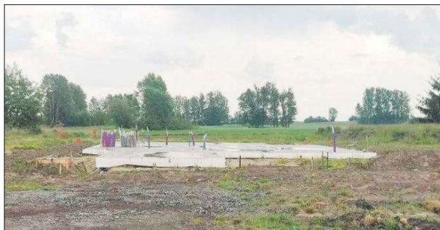
Wielu inwestorów zostało z samą płytą fundamentową
