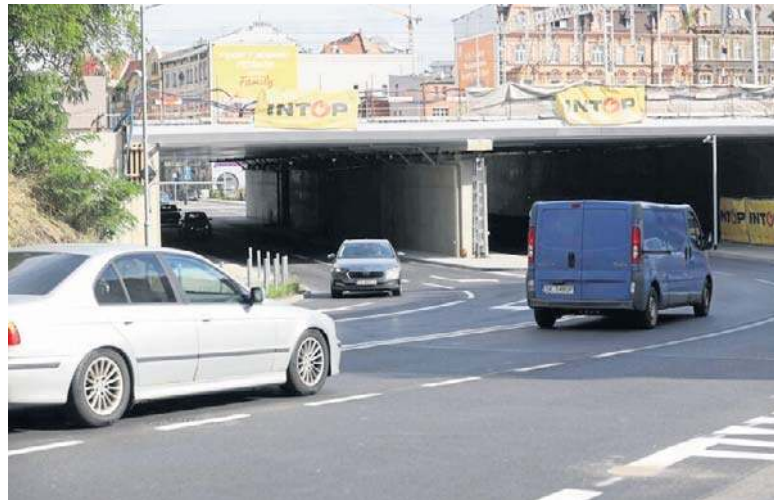
Wiadukt w ciągu ulicy Mikołowskiej znów jest przejezdny w obu kierunkach. Kierowcy czekali na to blisko dwa lata
