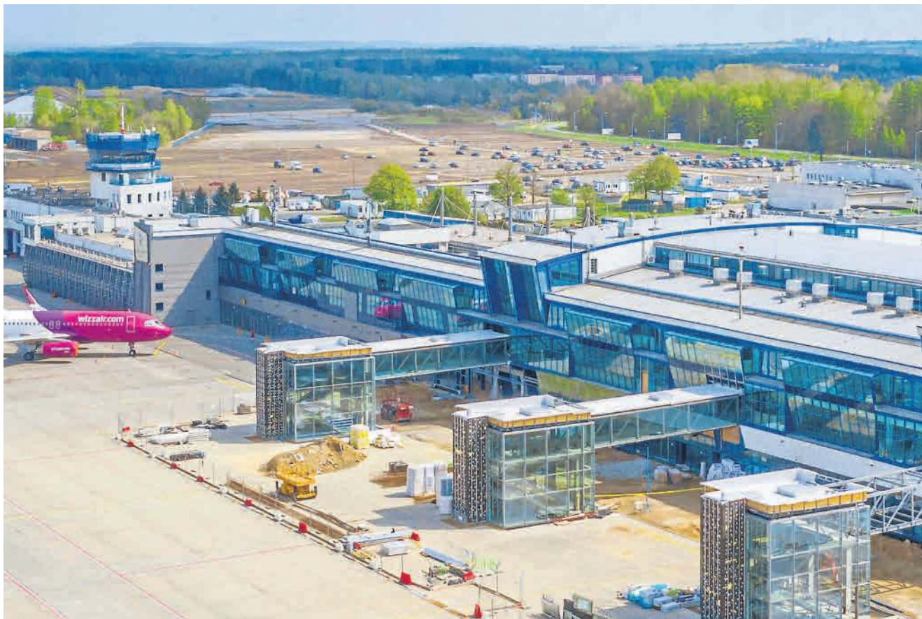
Tak wygląda obecnie terminal B na lotnisku w Pyrzowicach od strony płyty postojowej. Od jesieni 2019 trwa jego przebudowa, która skończy się przed wakacjami 2021. To są trzy nowe klatki schodowe - umożliwią boarding do sześciu samolotów
