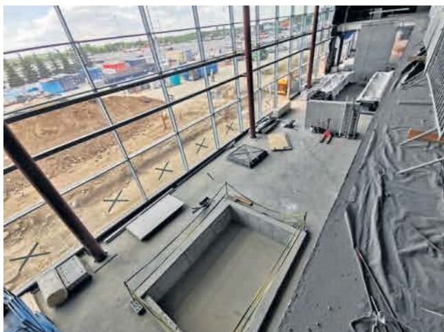
Terminal B, skąd latamy do strefy Schengen, przechodzi totalną przebudowę. Oto jego nowa część i przeszklona elewacja
