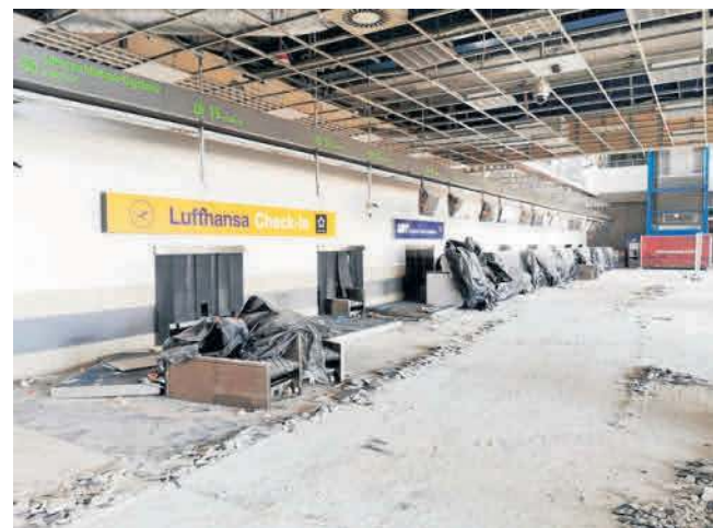
Choć z zewnątrz prace wyglądają na zaawansowane, w środku wszystko jest wypatroszone. Oto stanowiska odprawy
