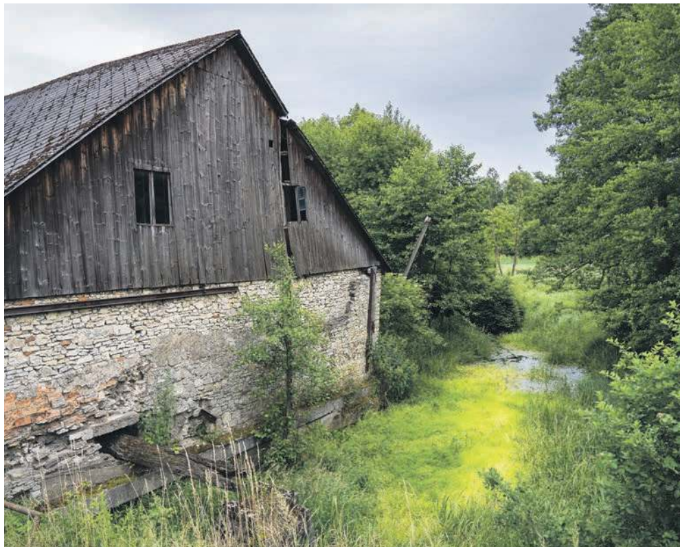
Widok od strony rzeki. Na pierwszym planie pozostałość po konstrukcji, na której zamocowane było koło młyńskie
