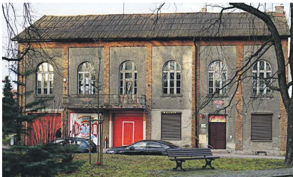
Remiza przy Śląskiej w Chrzanowie jest jednym z obiektów, które będą remontowane dzięki dotacji z ministerstwa kultury
