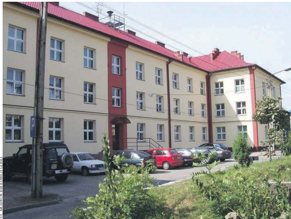
W budynku Zespołu Szkół Ekonomiczno-Chemicznych w Trzebini do końca wakacji mają zostać wyremontowane wszystkie łazienki
