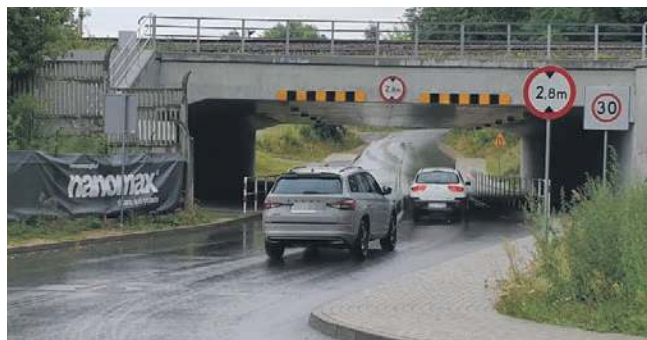
Na Zbożowej w Chrzanowie remontowana będzie sieć wodociągowa
