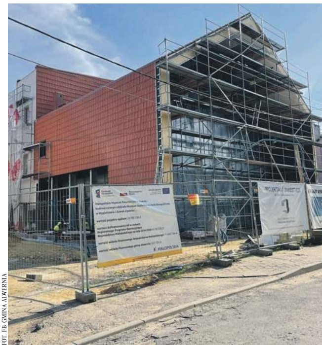
Trwa budowa nowej siedziby Muzeum Pożarnictwa w Alwerni
