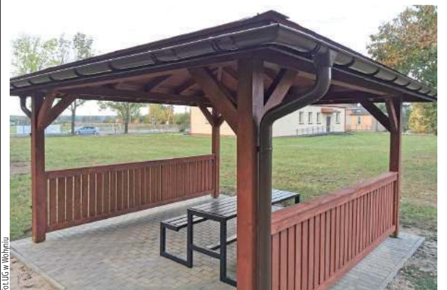
Wybudowano dwie altany turystyczne wraz z wyposażeniem w Świerżach i Wólce Zdunkówce. Planowana jest budowa kolejnych, w Branicy Suchowolskiej i Ossowie
