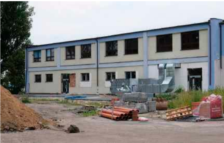
Do przebudowywanego budynku VII LO przy ul. Farbiarskiej licealiści i przedszkolaki najwcześniej wprowadzą się w październiku
