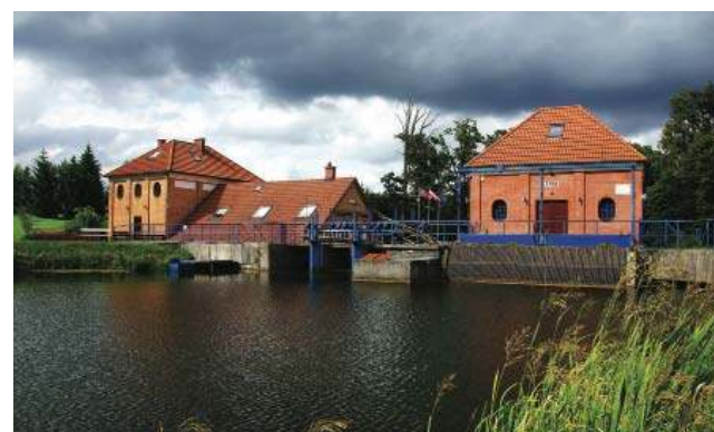
Tama i elektrownia wodna na Węgorapie w Ołowniku
