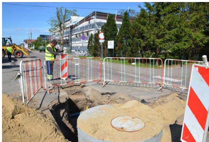
Roboty drogowe rozpoczęły się na ulicy Strażackiej, przy skrzyżowaniu z ulicą Szkolną.
